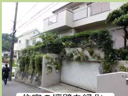
住宅の擁壁を緑化
