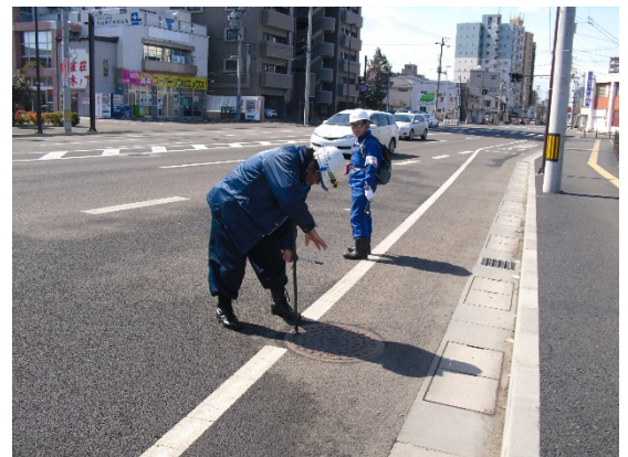
東日本大震災時の管きょ調査の様子
