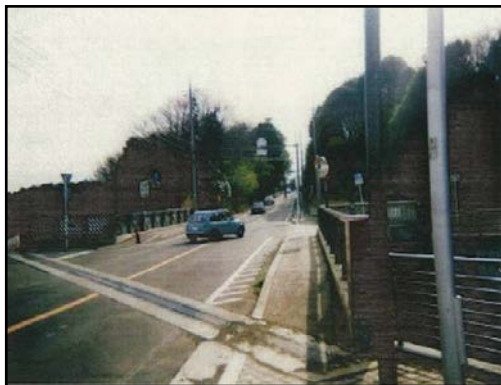
旧赤坂橋（工事着手前）
