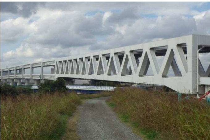
⑤ 大熊川トラス橋
