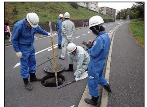
H27 下水道管等実地調査訓練の様子
