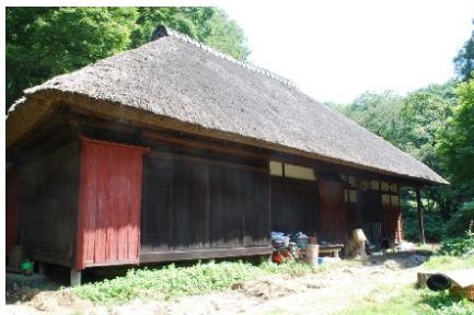
主屋（南側外観）
