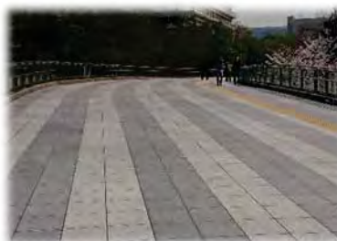
(横浜国際総合競技場 東ゲート橋)
