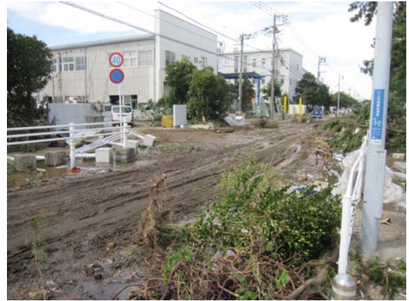
道路被災状況と工場
