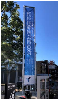
瀬谷区総合庁舎
